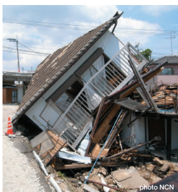
柱の座屈により倒壊した建物
